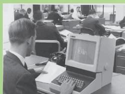
IBM 2260，使用CRT映像管的影像顯示終端機（Video display terminal），用螢幕輸出取代列印輸出。
